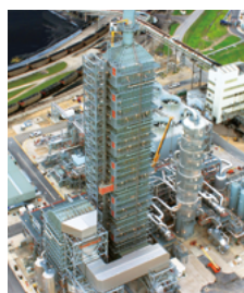
世界最大のCO 2 回収装置 (CO 2 回収量 4,776トン/日)
